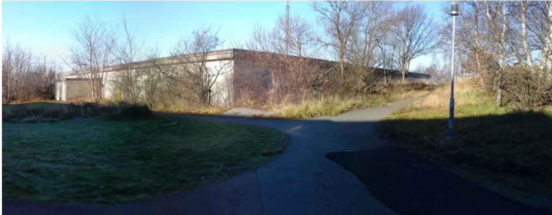
Figur 4 Befintlig gångbana norr om servicehemmet, uppe vid vattenreservoaren. Bilden tagen från söder.
