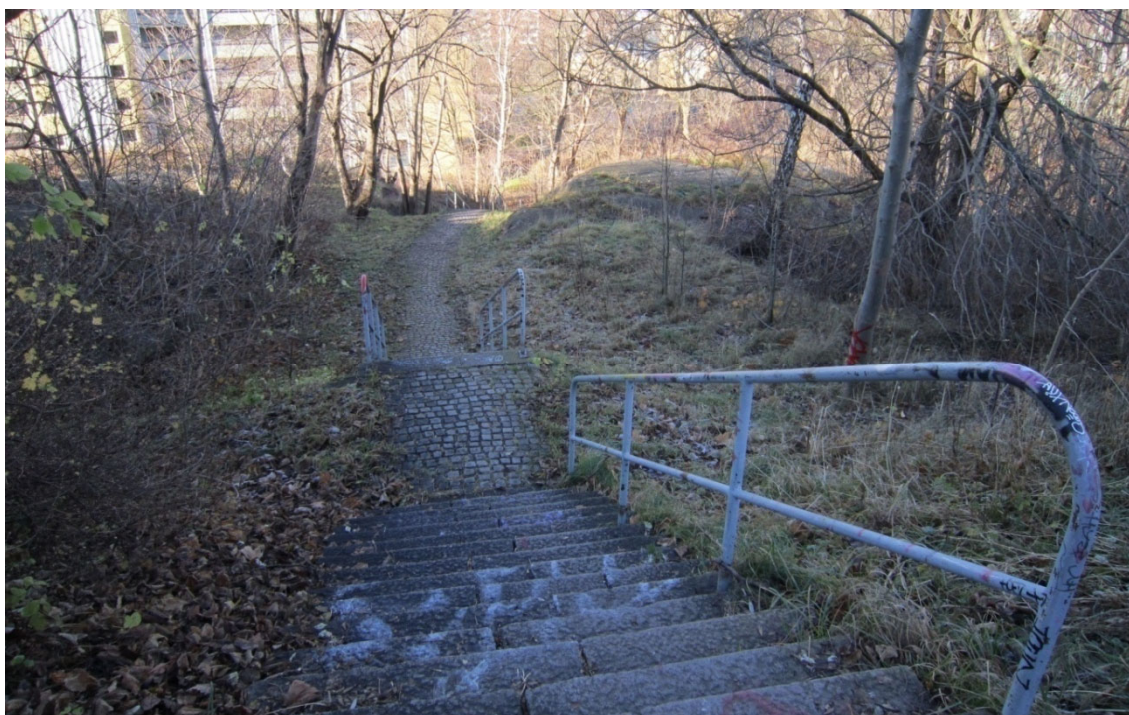
Figur 5 Befintlig gångbana ner från vattenreservoaren. Bilden tagen från sydöst.
