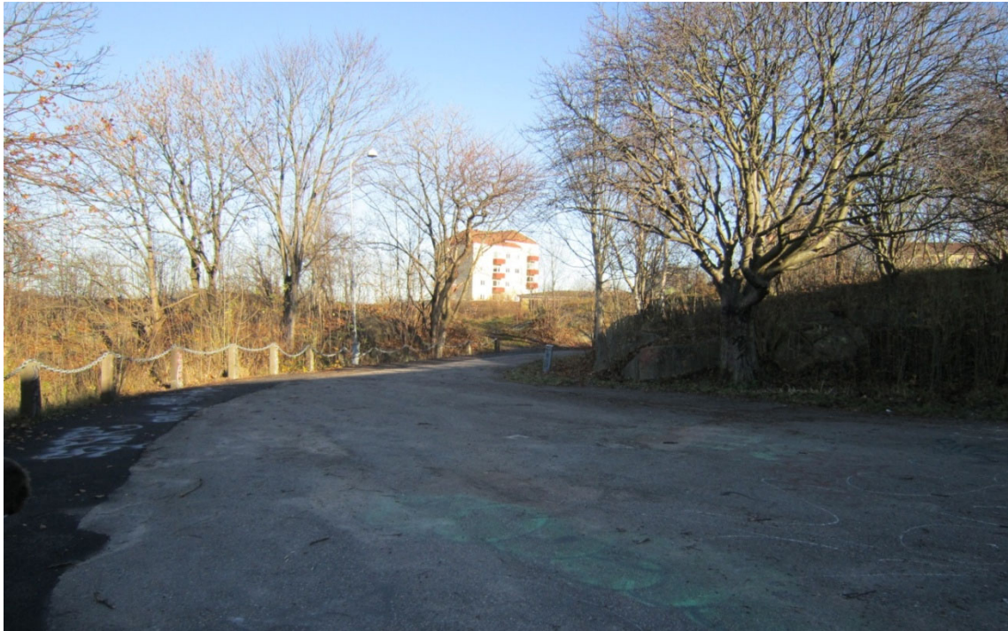
Figur 23 Den befintliga vändplanen framför vattenreservoaren. Bilden tagen från sydväst.
