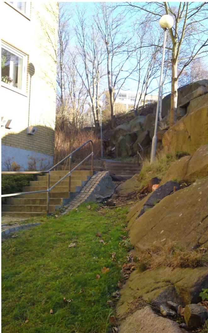
Figur 10 Befintlig gångbana. Två av de nedre trapporna som är placerade mellan befintligt hus och bergväggen. Bilden tagen från väster.
