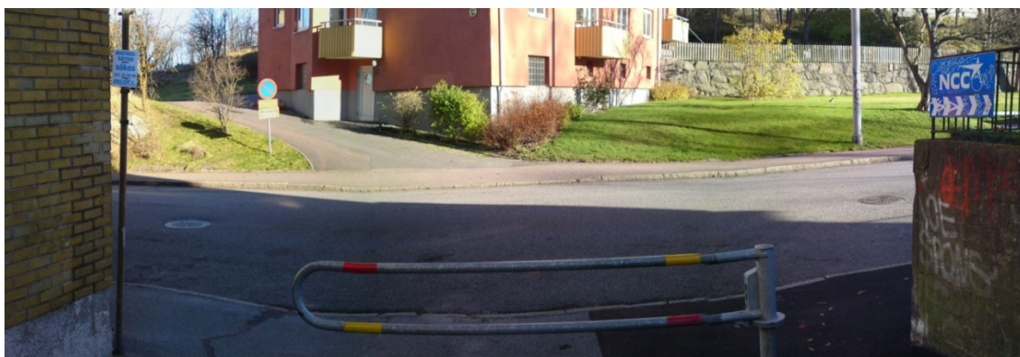
Figur 20 Ut mot Kabelgatan är sikten mycket begränsad. En bom förhindrar att obehörig trafik kör upp på vägen. Bilden tagen från väster.
