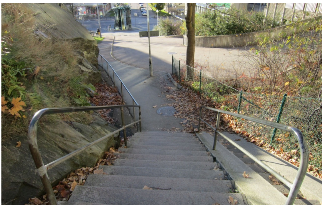
Figur 9 Befintlig gångbana. Första trappan upp från Slottsskogsgatan med tillhörande ramp. Bilden tagen från öster.
