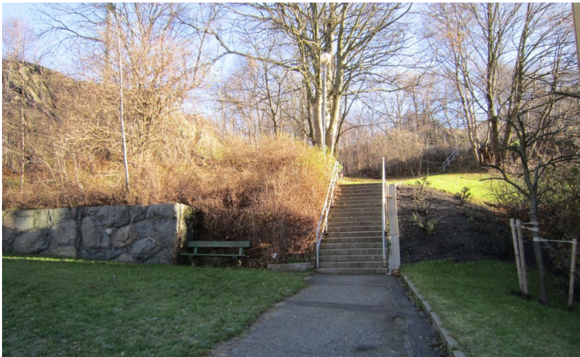
Figur 7 Befintlig gångbana upp från Seglaregatan. Bilden tagen från väster.
