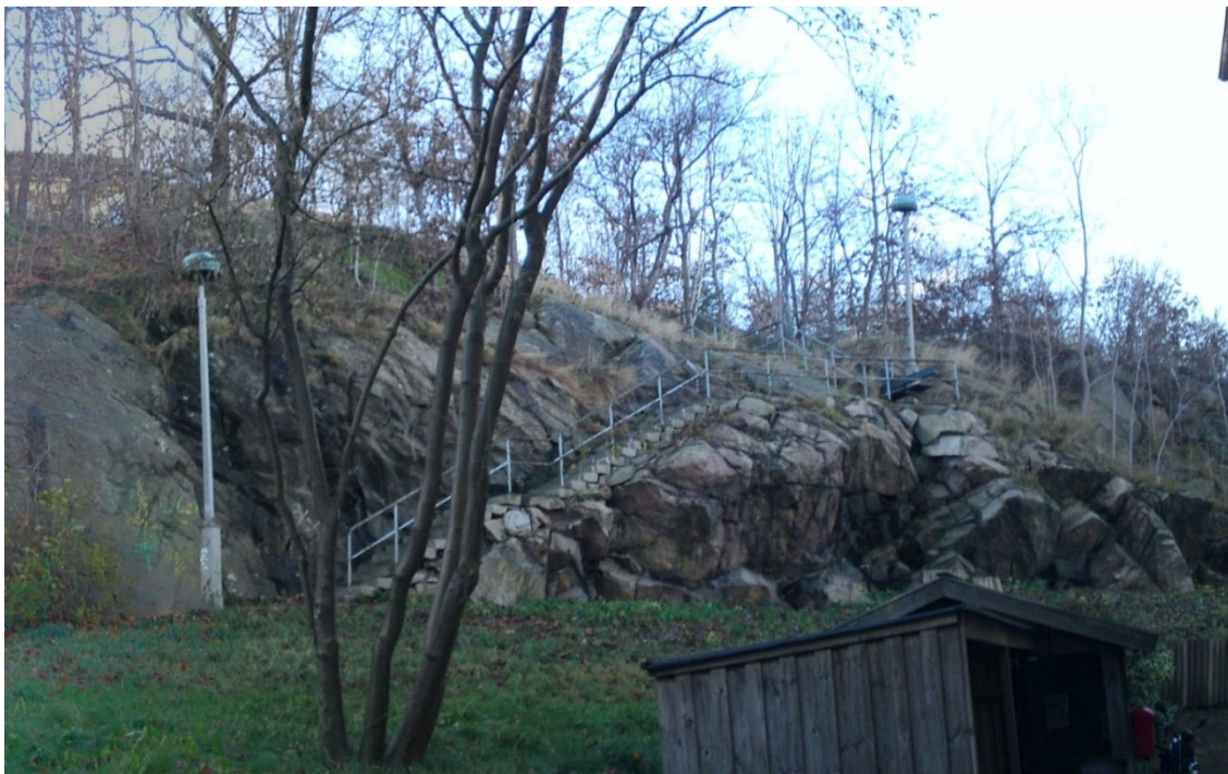
Figur 19 Befintlig gångbana. Den nedersta trappan på sträckan leder ner för en brant bergvägg. Att komplettera denna passage med en ramp skulle kräva omfattande ombyggnationer. Bilden tagen från öster.
