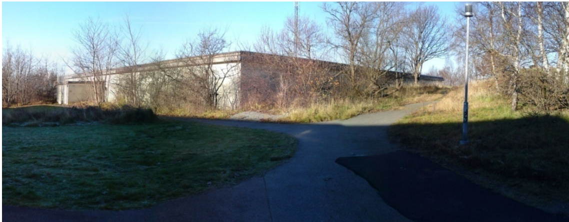
Figur 29 Området uppe vid vattenreservoaren. Bilden tagen från söder.
