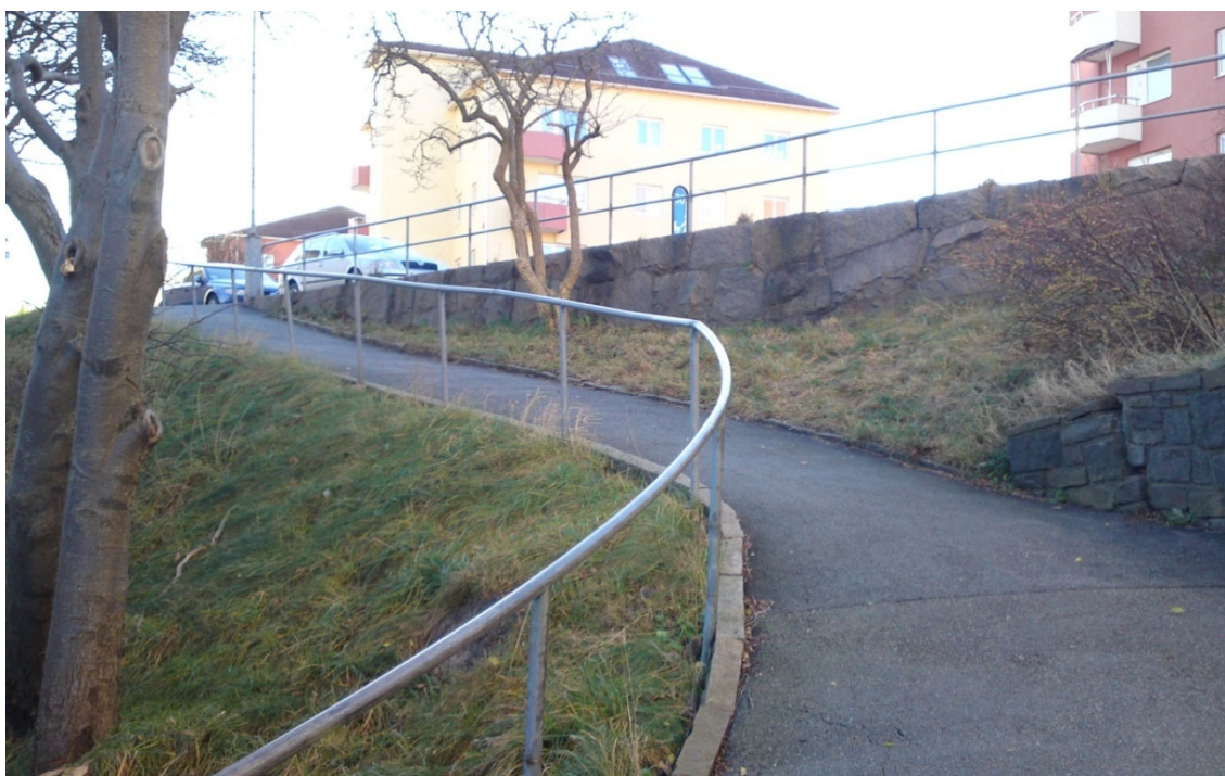
Figur 16 Befintlig gångbana. Bilden visar den branta sluttningen ner från Kabelgatan mot lekplatsen. Lutningen uppgår till 25 %. Bilden tagen från nordöst.
